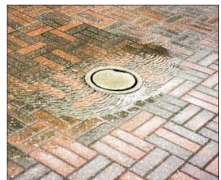
Lunker der giver vandsamlinger skal rettes op.
