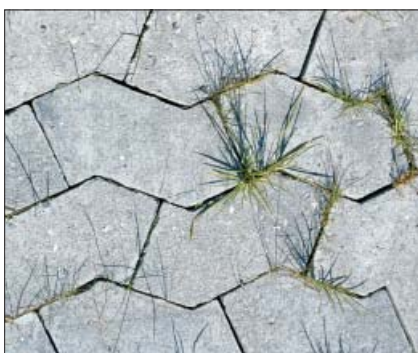
Ældre fyldte fuger har stor resistens mod ukrudt (øverst), mens nye halvtomme fuger giver gode vækstbetingelser for ukrudtet.
