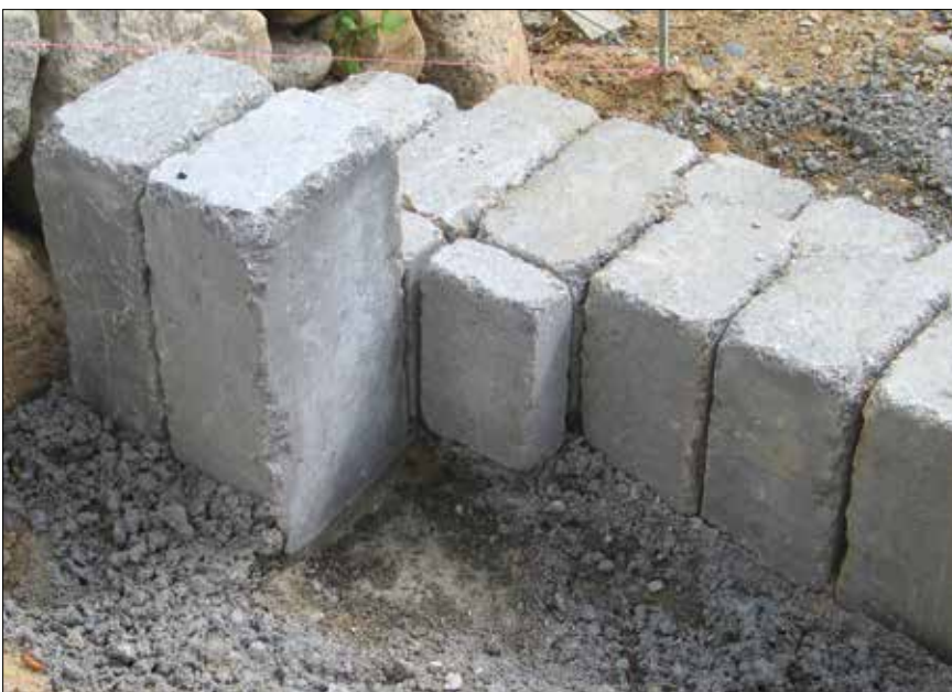
Figur 3.51. Sætning af trappe i jordfugtig beton.
