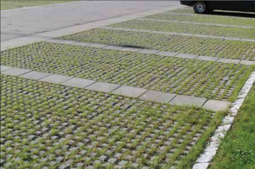
Figur 2.17. Græsarmeringssten benyttes ofte på parkeringsarealer.
