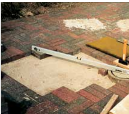
Figur 4.18. Ved brønddæksler og lignende opstår der ofte lunker på grund af for dårlig komprimering, eller manglende overhøjde ved lægningen. Oprettningen udføres dog let.
