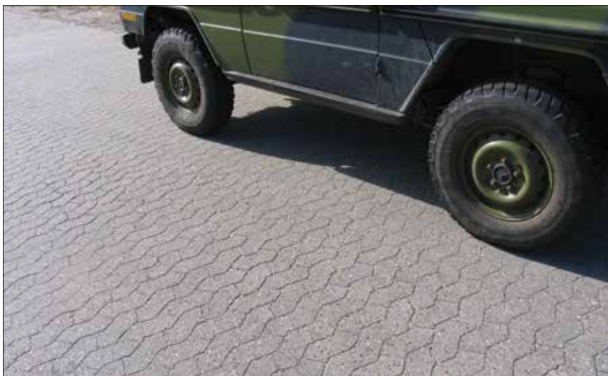
Figur 2.52. Militærareal med ca. 15 år gamle betonsten, der dagligt har været udsat for kørsel med bl.a. bæltekøretøjer. Stenene er kun slidt meget begrænset.
