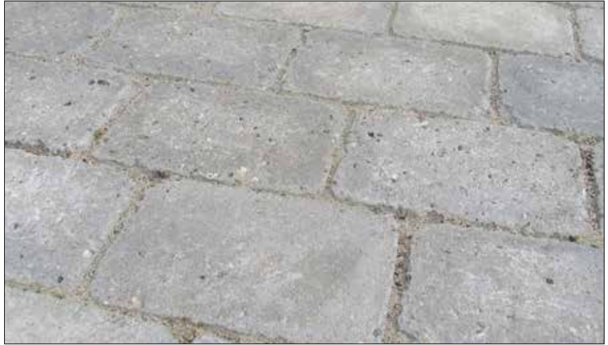
Figur 2.11. Et eksempel på efterbehandlede sten er betonsten med slåede kanter. Disse får et mere rustikt udseende.
