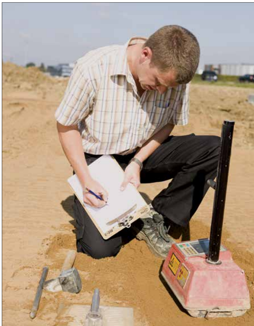
Figur 3.13. De forskellige lags komprimering kontrolleres oftest med en isotop-sonde. "Spydet" føres ned i jorden og jordens vandindhold og vådrumvægt bestemmes, og holdes op mod værdierne fundet i laboratoriet.
