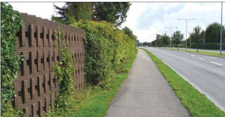
Figur 3.59. Støjmur. Muren er lavet åben for at kunne beplante den og for at reducere den støj der reflekteres.
